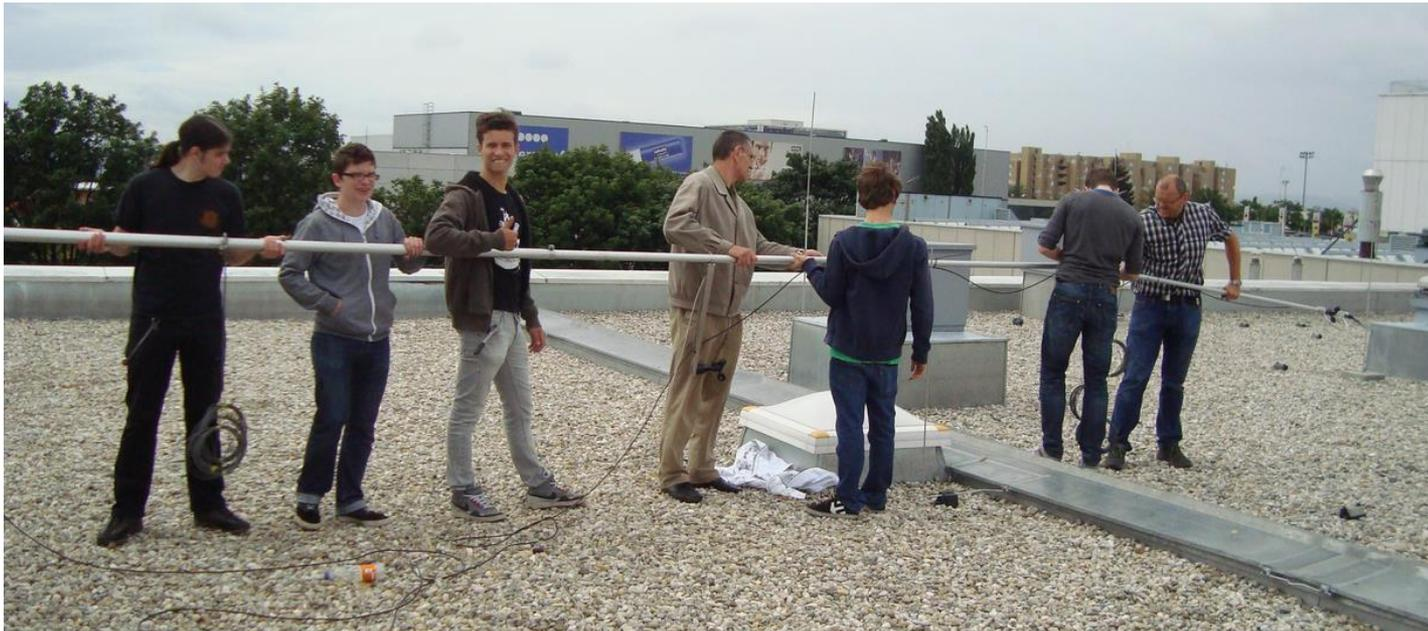
Zur Erweiterung der vorhandene Photovoltaik-Anlage wird versucht Kleinwindkraftwerke im Schulgelände zu errichten. Als Vorbereitung wird eine Windmessung mit zugehöriger Auswertung und Ermittlung von optimalen Standplätzen errichtet.
