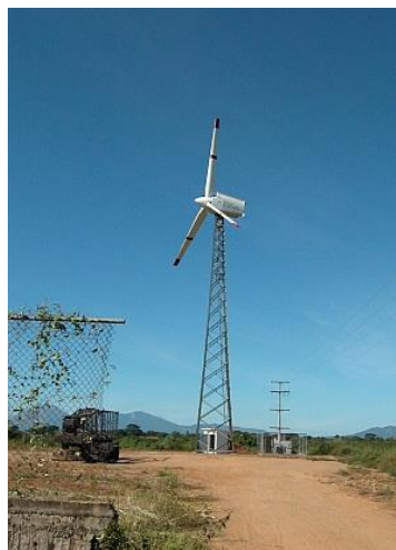
Solarthermieanlage in Bolivien, WEA in Nicaragua
