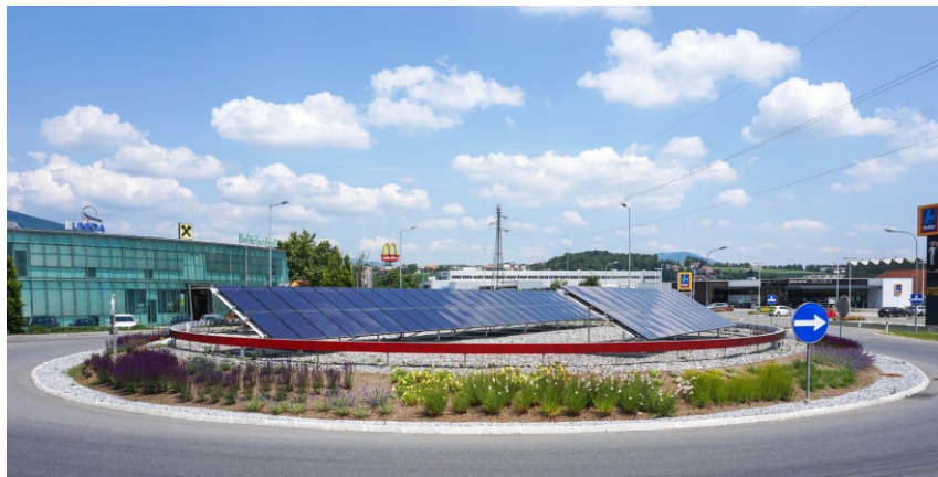
PV-Anlage beim Kreisverkehr Weiz
