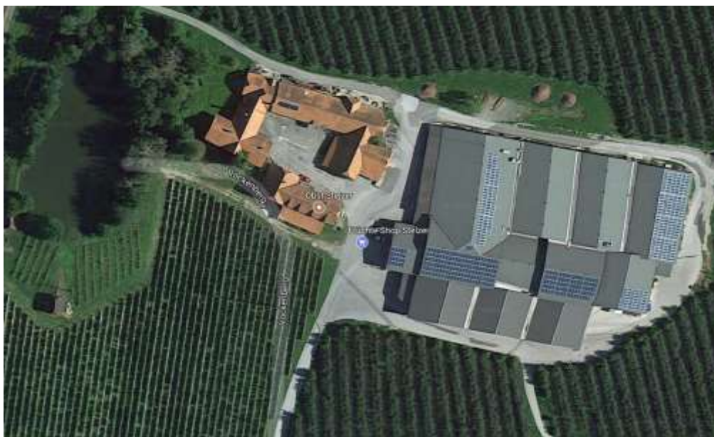
Stubenbergsee – Die aufgeschlossene Gemeindeverwaltung hat ein Leuchtturmprojekt geschaffen.
