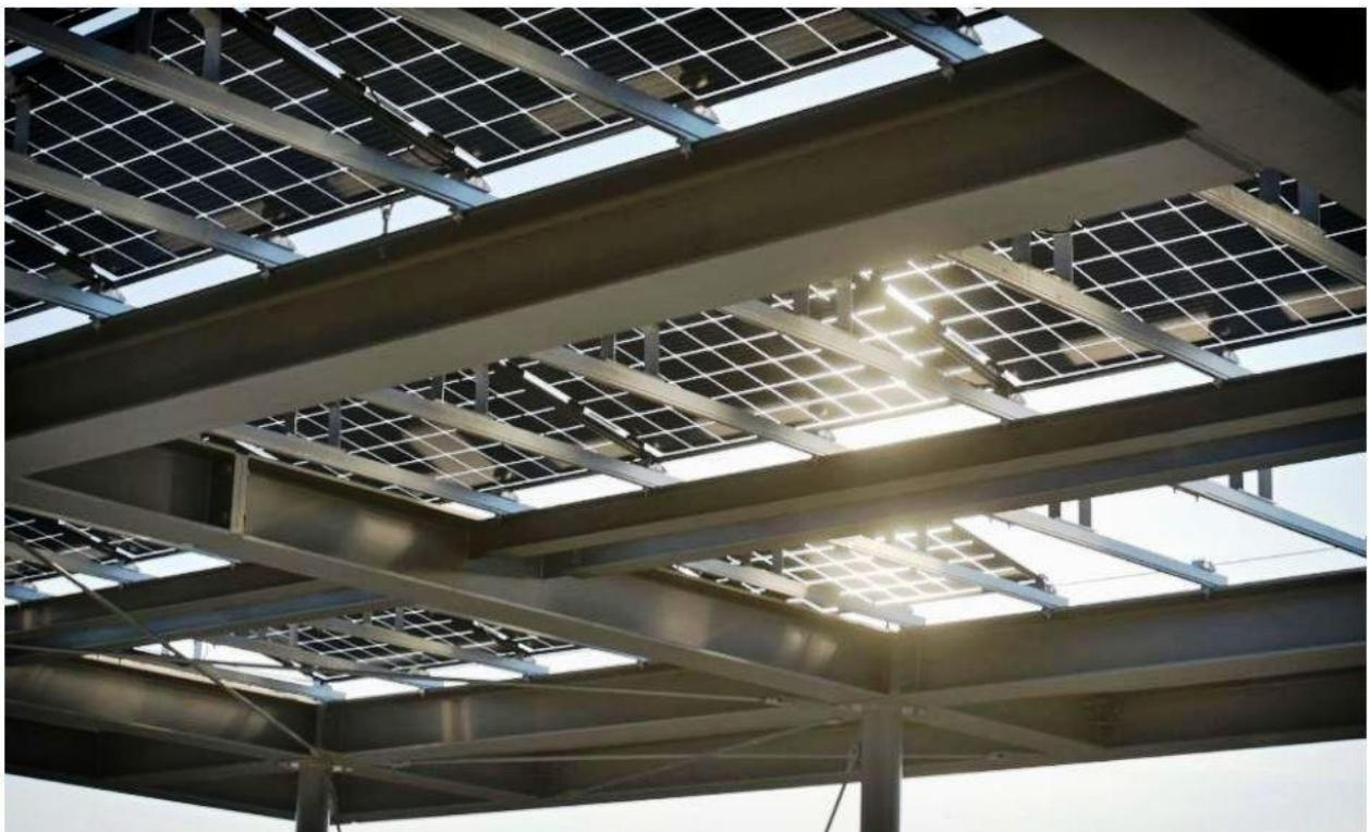
Bifaziale Module sind zweiseitige Zellen, die das einfallende Licht nicht nur über die Vorder-, sondern auch über die Rückseite nutzen können. Eine zweite Glasscheibe auf der hinteren Modulseite sorgt dafür, dass indirektes Licht durch reflektierte Sonnenstrahlen von hinten an die Zellen gelangt. Die beidseitige Nutzung erhöht die Stromerträge derzeit standortabhängig typischerweise um 5-10%. So erzielt das Modul einen höheren Wirkungsgrad.
