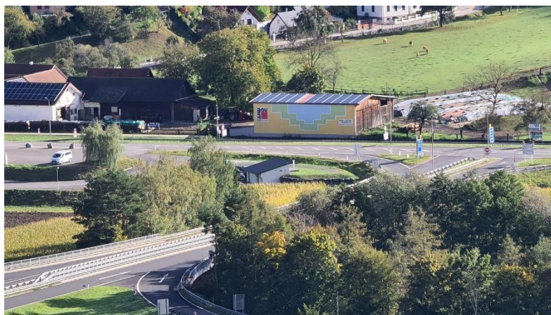
PV Anlage Petersbaumgarten Gesamtansicht
