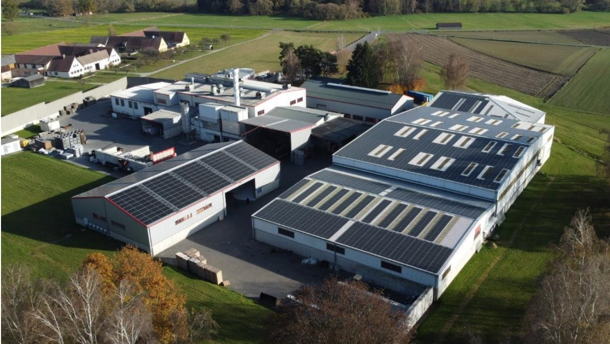
Luftaufnahme der Hütte Klein-Reichenbach GmbH; im Vordergrund die Auslieferung- und Schrotthalle mit der PV-Anlage, im Hintergrund die Produktionshalle mit dem Schmelzofen.
