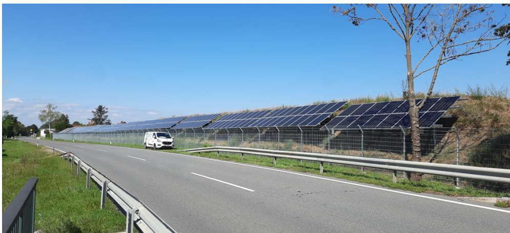
Erdlärmschutzwall bei der B34 in Fels mit knapp 100 kWp
